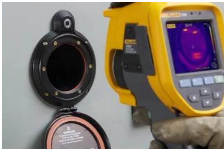
Figura 36: Exemplo de aplicação de janela de inspeção termográfica.
